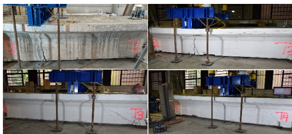
Figura 17. Fisuración en rotura en los 4 ensayos.
