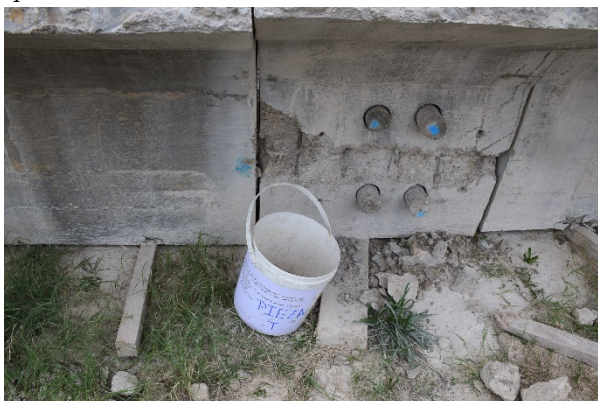
Figura 7. Testigos extraídos de la zona central del vano destinado a las piezas T de longitud limitada.
