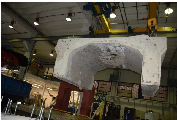
Figura 14. Vista inferior de la pieza 3 al final del ensayo.
