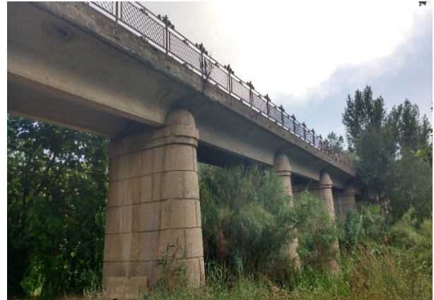
Figura 1. Vista general del puente estudiado.
