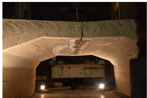
Figura 12. Vista inferior de la pieza 2 al final del ensayo.
